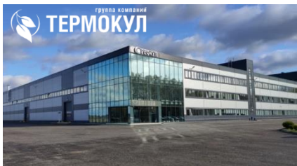
Фасад завода «РЕФКУЛ»
