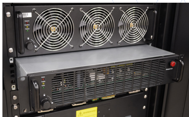
Рисунок 3. Модуль статического байпаса с «горячей» заменой
